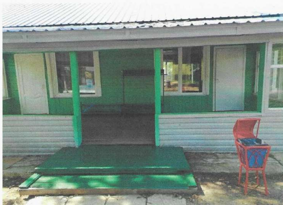
Фото № 18, 19, 20: Входная площадка
