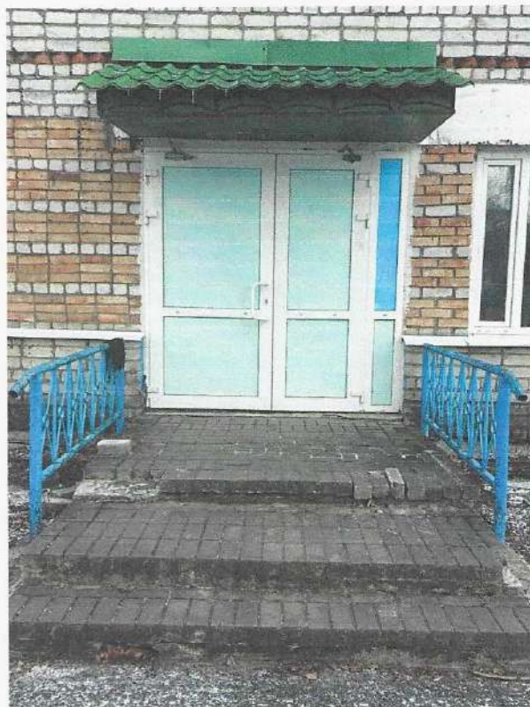
Фото № 29: Входная площадка
