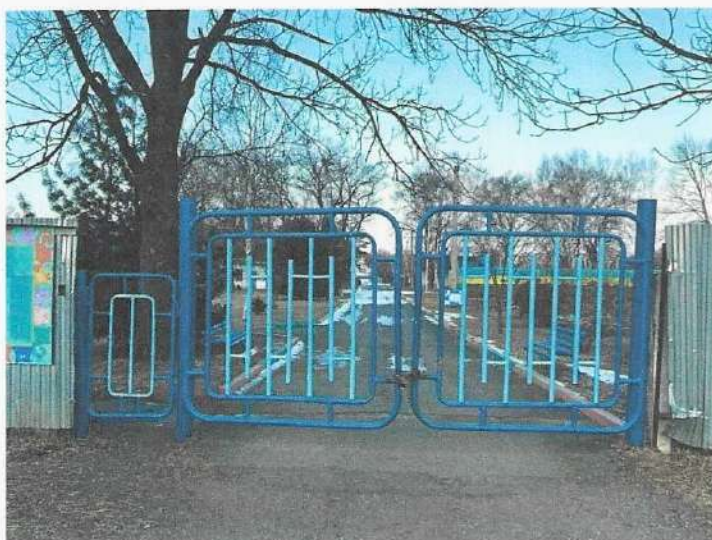
Фото № 1: Вход на территорию 1
