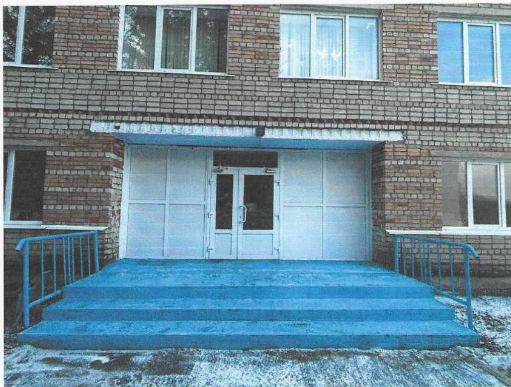
Фото № 30: Входная площадка
